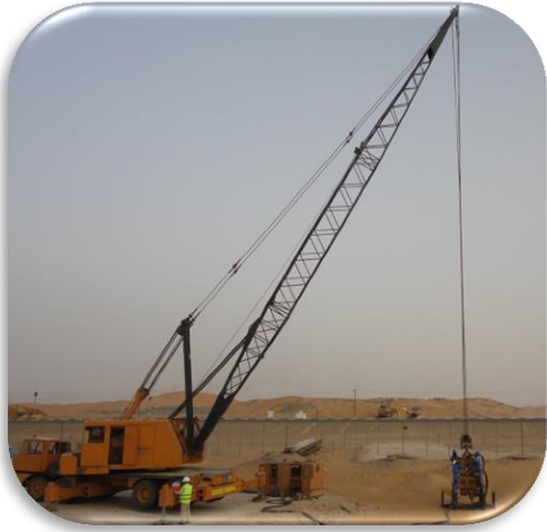
70 Ton Lorrain Crane
